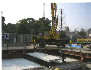
6 プレキャストスラブ材の布設
