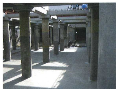
5 底版コンクリート打設
