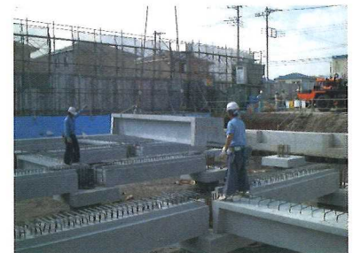
3 プレキャスト梁部材の設置
