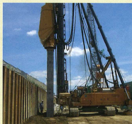
下部材の沈設
