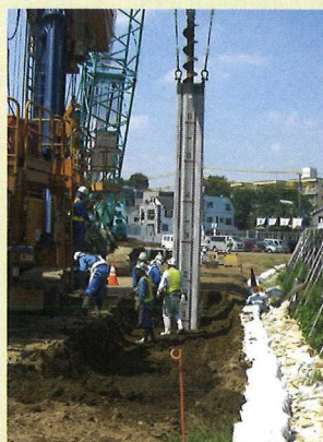
下部材の建込み
