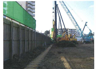
1 PC-壁体・中柱の施工
