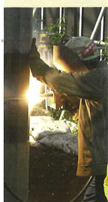
込み・継手溶接
