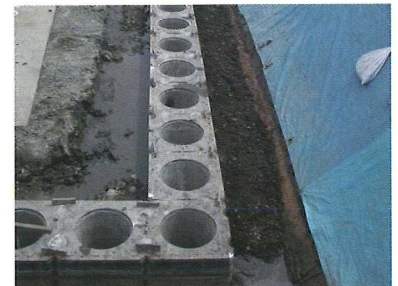
2 PC-壁体施工完了
