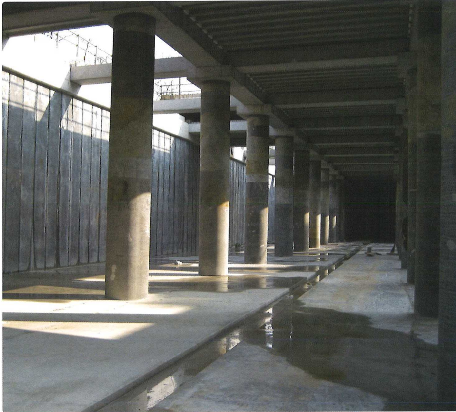
1 PC-壁体・中柱の施工
