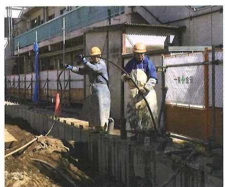
モルタル注入
