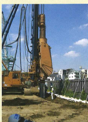
上部材の沈設
