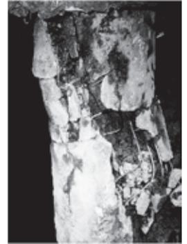
杭頭を剛接した杭の被害例
