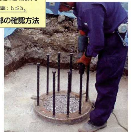
写真1 締付け状況
