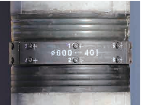
トルクチェック完了後、プレートにマーキングする。
